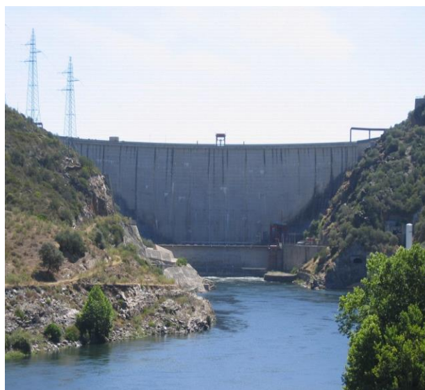
Presa de Valdecañas
