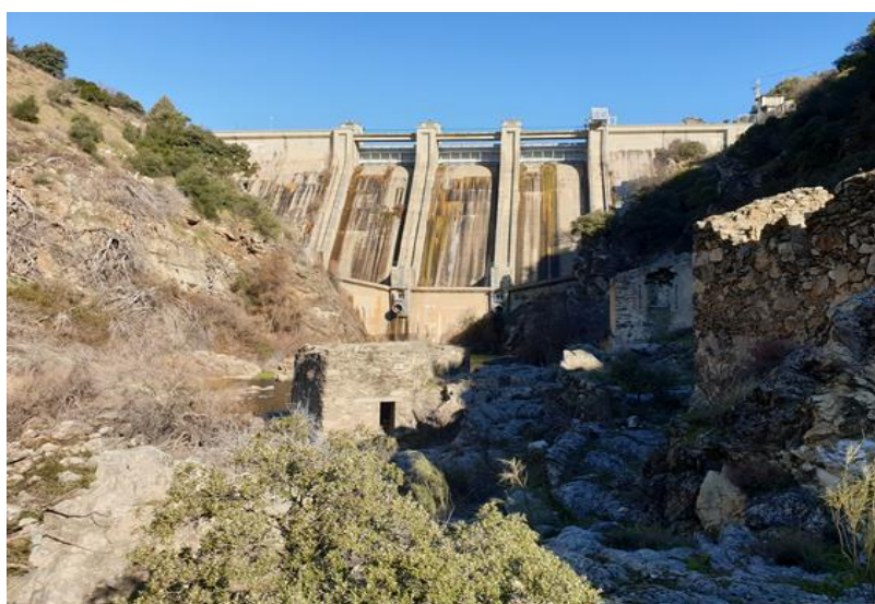
Presa de Picadas
