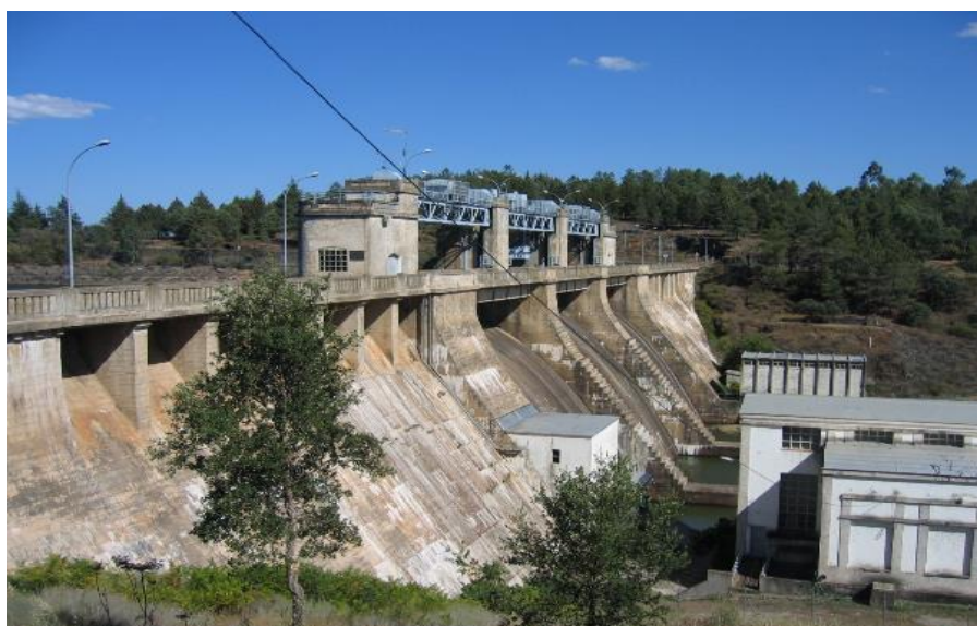
Presa de Borbollón
